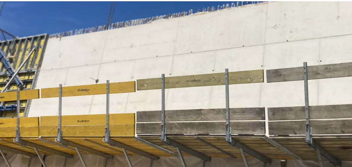
Probewand mit ausschließlich saugender Schalung
