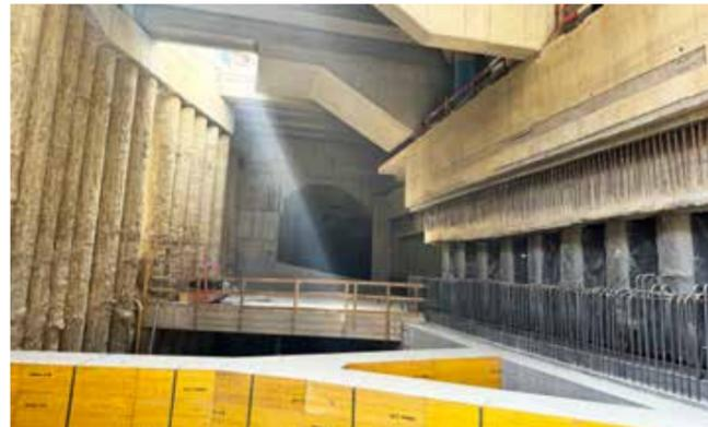
Drehkreuz: U-Bahn-Station U2&U5, die links im Bild befindlichen Bohrpfähle, die beim Schachtbau als Stütze dienten, werden später, wenn die Decken und Träger eingebaut sind wieder abgerissen.
