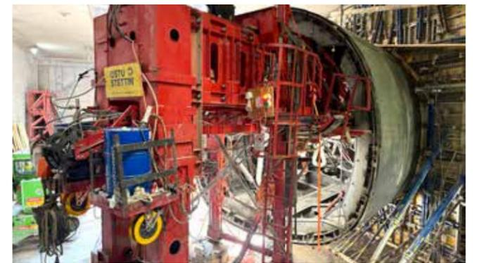
Über unsere Betonpumpe wird der Beton in diesen Schalwagen über Schlauchleitungen eingebracht. So wird der U-Bahn-Tunnel mit Beton fertig ausgekleidet.
