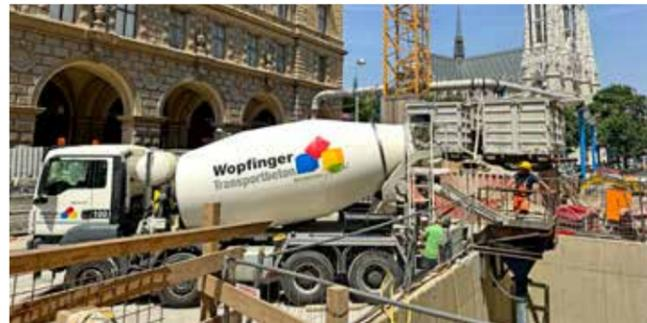
So kommt der Beton vom FM über die Pumpe in den U-Bahn-Schacht.
