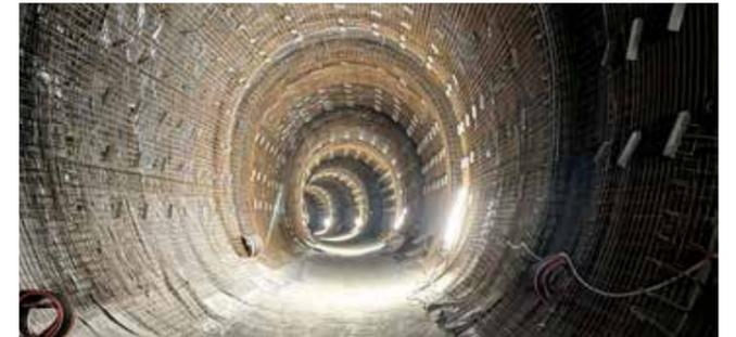
U-Bahn-Tunnel mit Eisenmatten vorbereitet bevor er mit Beton ausgekleidet wird.
